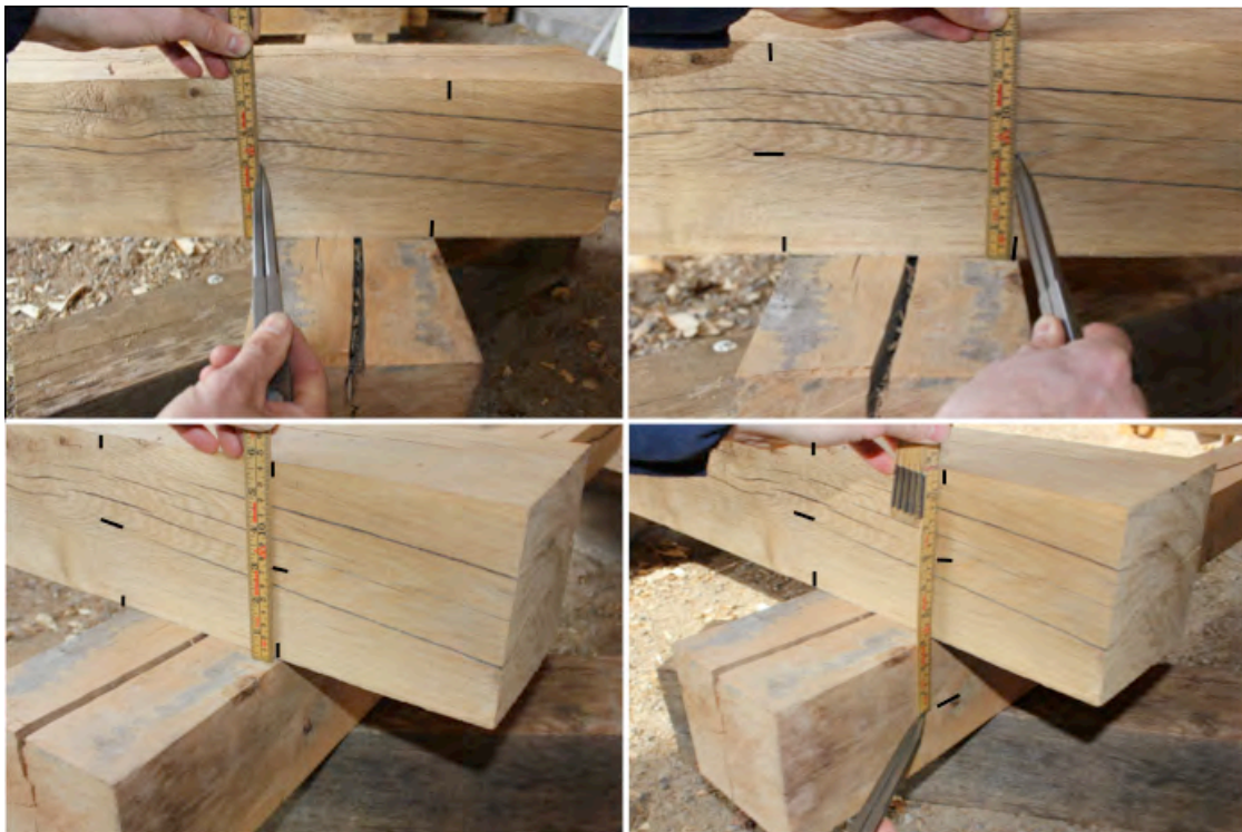
Figur 24. Uttag och påritning av hak med tumstock. Svart markering utgör ritsmärken, som sedan sammanbands för att få ut linjer för hak och uthuggning.
