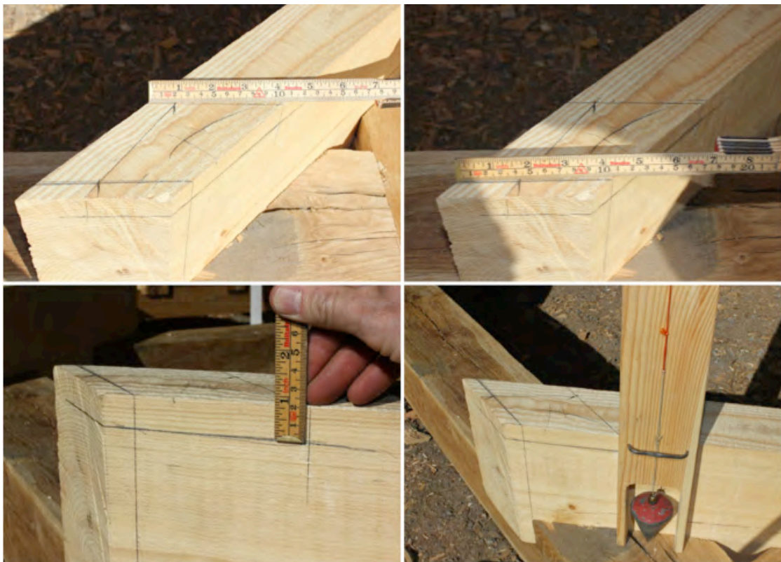
Figur 51. Timrets överhak påritades med tumstock, \frac{1}{5} av timret i bakkant gav 21 mm och \frac{2}{5} av timret i framkant gav 42 mm. Hakets djup påritades vinkelrätt ner med \frac{1}{7} av uppsticket, vilket gav 20 mm. Hakets djup lodades ner i början med lodaln. Efterhand gjordes det med tumstocken, samtidigt som djupet
