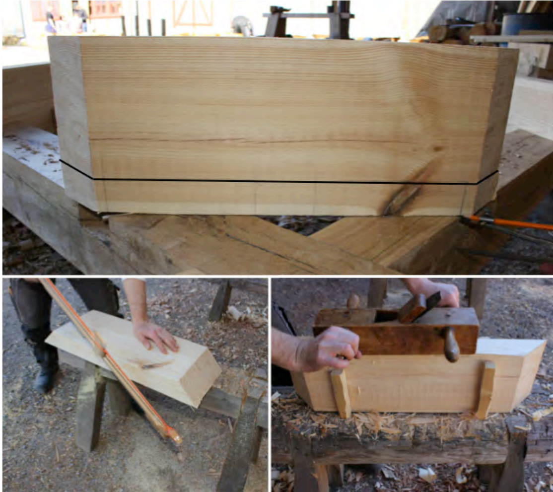
Figur 43. Timret inplacerades i lod och våg. Överskjutande höjd timret, för att uppstick skulle stämma med nästkommande timret och övriga redan intimrade togs med passare och avsattes på timret, svart markering på bilden. Materialet sågades bort och timrets undersida justerades med oxhyveln.
