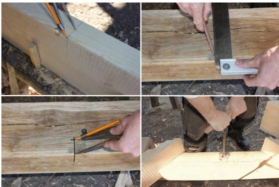
Figur 69. Fortsättningen på att ”tolka upp en dubb”. Efter att lodmarkeringen vinklats över på undersidan timret, togs halva bredden ut med passare och avsattes från framsidan timret. Därefter gjordes, med passarens stålben, ett hål för navarens skruv att få fäste i. Lodmarkeringen för dubbens placering vinklades över på fotträramen. Timrets halva bredd avsattes på fotträet från dess framkant och ett hål för navaren
