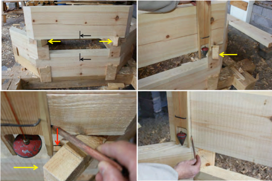
Figur 65. Timret inplacerades i lod och våg, här användes kilar – gula pilar, för att hålla timret i position. Den halva laxstjärten i plan gjorde att timret inte kunde vila nere i överhaket, för då försköts timret ut. "Huggens ritser" lodades upp från underliggande timret på fram- och baksida. För upplodning baksidan; är underliggande timret i lod kan lodaln placeras som på bilden ovanpå det underliggande timret. Är inte underliggande timret i lod måste dess lutning överföras till nästkommande timret och då får lodaln placeras på sidan av det underliggande timret. Här placerades lodaln ovanpå även för att synliggöra streckdragningen. Svarta pilar visar lodmarkering för dubb. Röd pil visar markering för överhakets ytterhörna i det underliggande timret. Det utgör lodpunkten och där lodning gjordes för "huggens ritser".
