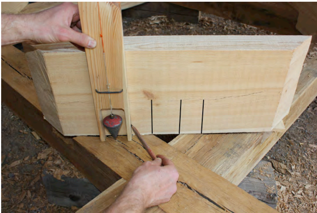
Figur 40. Timret placerades in i lod och våg ovan haken. Låsacken i vardera haken lodas upp i timret, både på framsida och baksida.
