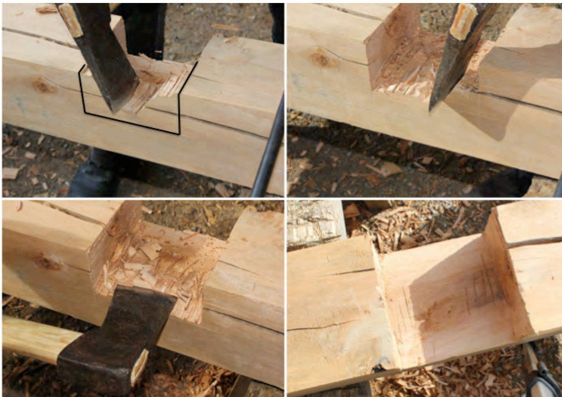
Figur 7. Därefter höggs andra sidan helt ut och sedan justerades hela haket.
