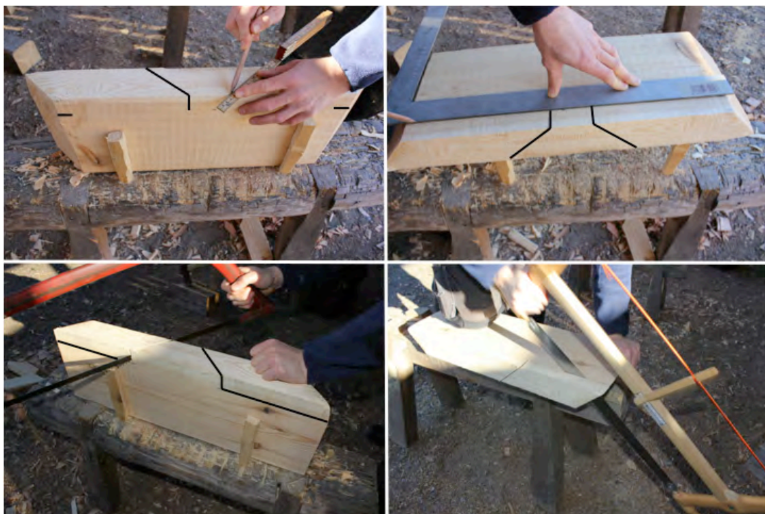
Figur 48. Lodlinjerna för urtag förbands på undersidan för sågning. Passarmarkeringarna för timrets sänkning förbands med timmermansvinkeln inför sågning. Materialet sågades bort med kap och klyvsåg.
