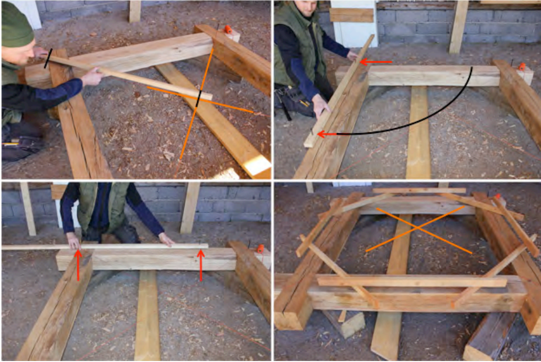
Figur 28. Likvärdigt prov med tumstock spändes ett snöre upp. Avståndet togs ut med ett rakt läkt som förseddes med två igenom spikade smidda spik, på avståndet ytterkant fotträram och krysset som snöret bildade, se bild uppe till vänster. För tillverkning av verktyget – passaren, se Bilaga 2 Figur 8-10. Avståndet avsattes på fotträramen med läkten utgörande en passare, genom att det ena spiken låg an som stopp i fotträhörnet och det andra kunde ritsa/avsätt avståndet på fotträet. Proceduren upprepades för varje hörn och bildade markeringar som sedan bands ihop och bildade en liksidig åttahörning, som bild nere till höger visar. Korta läkt är placerade för att illustrera oktagonen.
