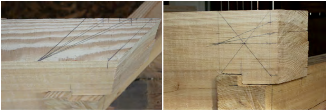
Figur 54. Påritning av halv laxstjärta i plan med mått enligt Sjömars tolkning. Det första strecket av de två längst till höger, i vänstra bilden, visar Sjömars tolkning \frac{2}{3} av timret, se avsnitt 2.4. Detta lämnar inte mycket kvar av material i nästkommande timret. De två närliggande strecken längst till vänster utgör det som provades vid genomförandet. Haket gjordes först \frac{1}{4} av timret enligt Rotstein. Sedan \frac{1}{3} för att knyta an till Sjömars tolkning och för att det blev lättare att hugga ut när haket inte var allt för litet. Detta kan förklara, som vid infästningen i fotträramen, Sjömars större hak. Bilden till vänster visar påritning för vinkel till Prov 1. Den övre påritades först, enligt Sjömars tolkning, om att vinkeln skulle gå från hälften av uppsticket till \frac{3}{4} av uppsticket. Detta gav en skarpare vinkel i förhållande till den som togs ut efter hans mått i skiss, om en fast vinkel. Den undre vinkeln visar uttag enligt principen halva diagonalen av uppsticket, som utgjorde nästan samma vinkel som Sjömars vid uttag av fast vinkel, se avsnitt 2.4 Figur 12. Halva diagonalen av uppsticket, som gav vinkeln, var det som sedan användes genomgående i rekonstruktionen.
