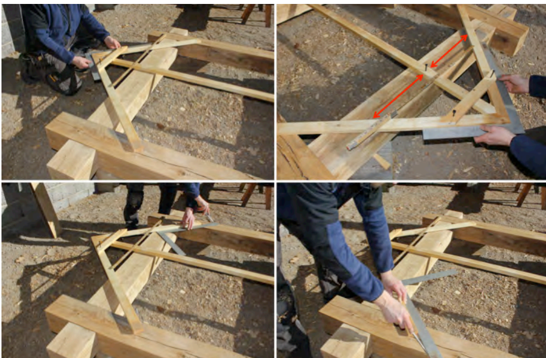
Figur 31. En större vinkel i 90^\circ tillverkades, som sedan användes för att illustrera ett hörn av kvadraten och för påitning av oktagonens snedställda sidor. Timmermansvinkel hölls i bakkant av den tillverkade 90^\circ -vinkeln för att stabilisera och kalibrera. Tumstocken användes för att kontrollera att trävinkeln fördelades lika i förhållande till läkten. Trävinkeln hade gjorts för kort och timmermansvinkeln fick användas som förlängning för att kunna rita på. Illustration av oktagonerna se Figur 28.
