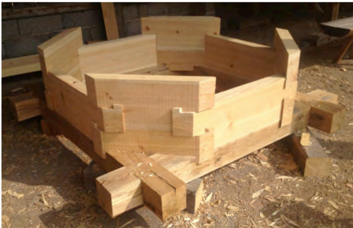
Figur 82. Brunnskaret efter att första varvet är intimrat och andra varvet påbörjat. Holmbergs knut är den som syns.
