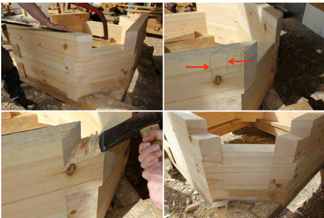
Figur 61. Sedan sågades haket bakkant och ett ytterligare snitt i mitten, se röda pilar, för att lättare kunna hugga ut haken.
