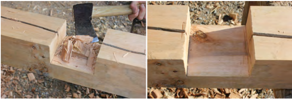
Figur 5. Sista kilbiten höggs bort och haket finjusterades.
