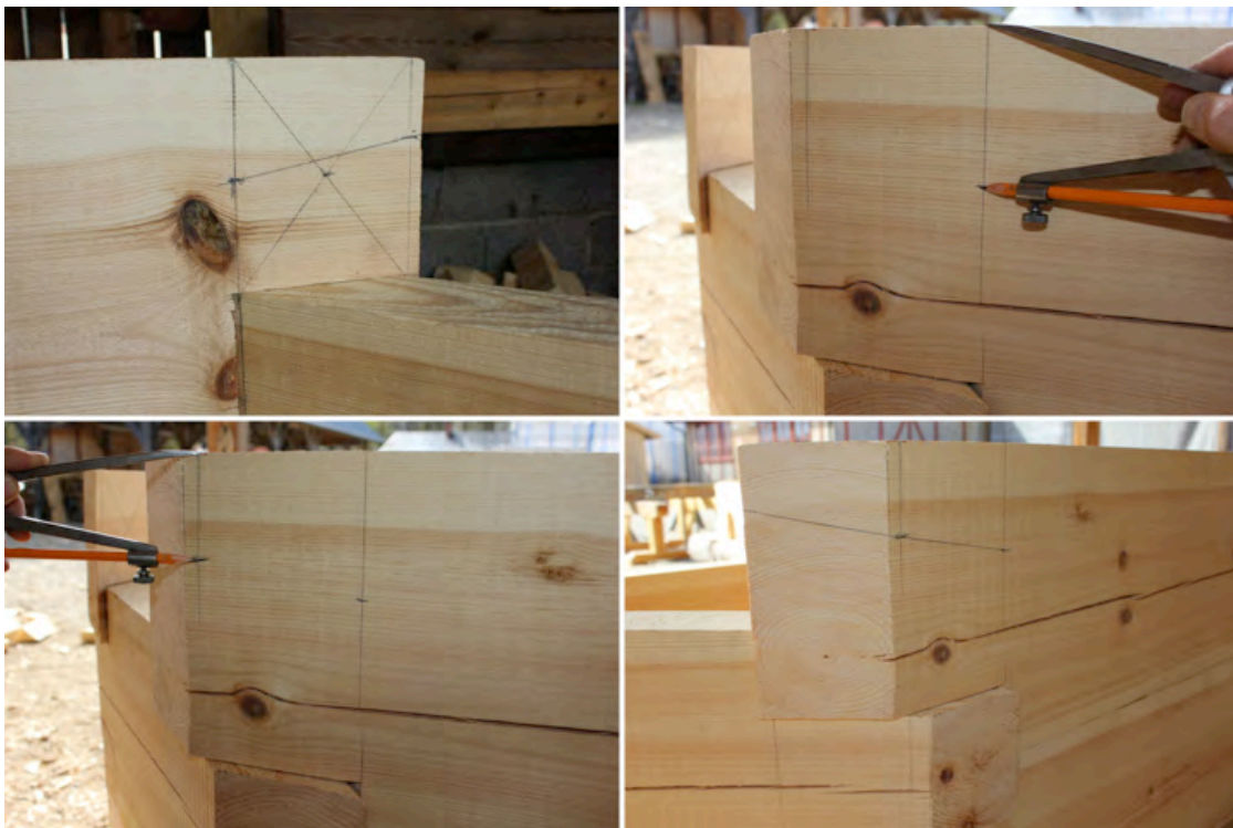
Figur 60. På framsidan gjordes likadant fast då sattes halv diagonalen av från ovankant timret i knutens bakkant och halv uppsticket från ovankant timret i knutens framkant.
