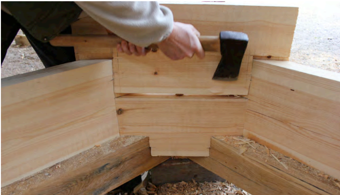
Figur 75. Istället för att rita på, syftades och högs timret på plats direkt.
