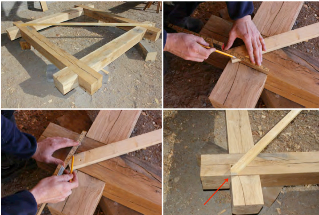
Figur 29. Ett läkt placerades som räckte över fotträramens diagonal. En spets skapades i 45°-vinkel i var ände på läkten genom att syfta och rita på, som sedan sågades ut.
