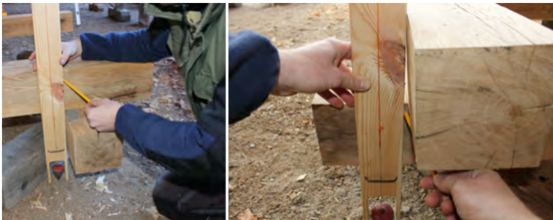
Figur 22. För båda alternativen överförs först fotträns form till varandra där haken ska var genom lodning.
