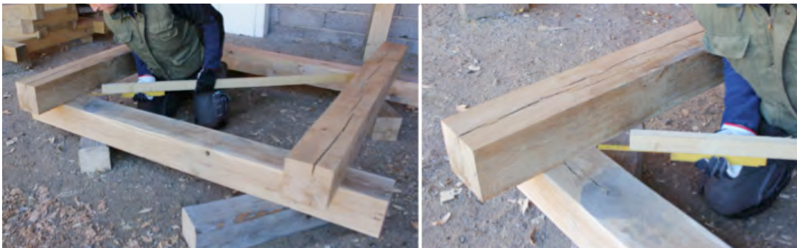
Figur 21. Kryssmätning av fotträramen för vinkelräthet.
