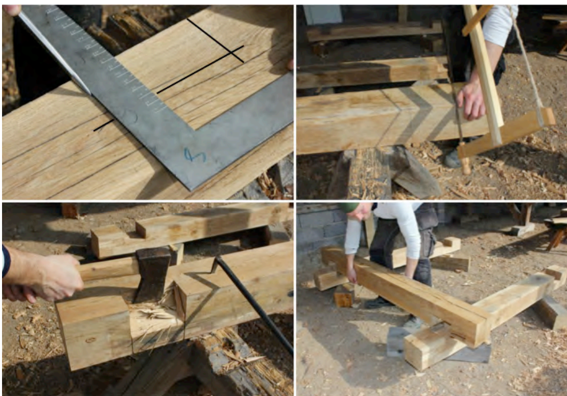
Figur 25. Linjer ritats för haket efter påritningens markeringar med timmermansvinkeln. Hakets yttersidor sågas med ställningssåg. Fotträet läggs på sidan och huggs ut till ca mitten med timmeryxan, fotträet vänds och huggs likvärdigt på andra sidan.
