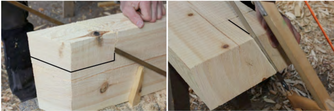
Figur 72. Timret placeras upp och ner i timmerbocken och lodmarkeringarna förbinds på timrets undersida och passarens markering på sidorna. Därefter sågades underhaket större del ut.
