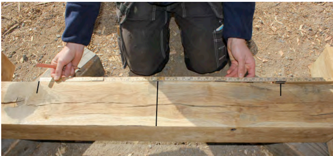
Figur 32. Utsättning och centrering av timrets främre längd på fotträramen gjordes med tumstock efter centrumstrecket från utsättning av fotträramens yttermått. Det längre svarta sträcket utgör centrumlinje. Längden kom från analys av Holmbergs teckning, vilket uppgav i genomsnitt 800 mm för det längre timret. Utsättning gjordes på alla fotträets sidor. Markeringarna bands samman och skapade den åttkantiga asymmetriska formen.
