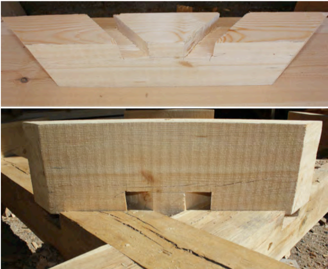
Figur 42. Lodritsarnas markeringar bands samman på undersidan och haken för låsnackarna sågades och höggs ut. Materialet som skulle tas bort för att timret skulle kunna sänkas till 140 i uppstick sågades bort i hela timrets längd för att förenkla vid infästning. Biten som skulle varit kvar i mitten på timret skulle inte fyllt någon funktion då infästningen med dess två låsnackar och försänkning av 50 mm ner i haken var mer än väl stabilt ändå.
