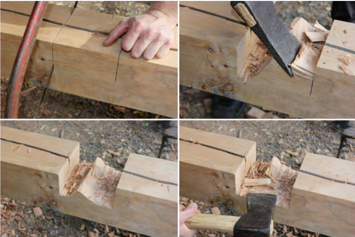
Figur 4. Fotträet placerades med haket vänt uppåt. Hakets yttersidor sågades ut. Därefter höggs haket ut med att först hugga snett ner för att bilda en kil som sedan höggs bort från sidorna.
