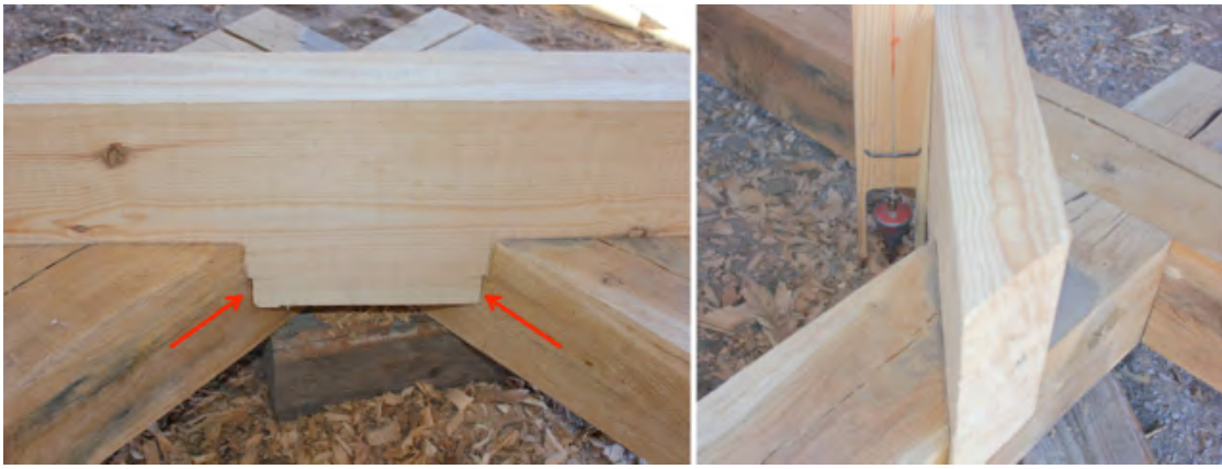
Figur 49. Timret inplacerades, pilar visar timrets försänkning under fotträramens hak. Timret kontrollerades att det efter intimring var i lod.
