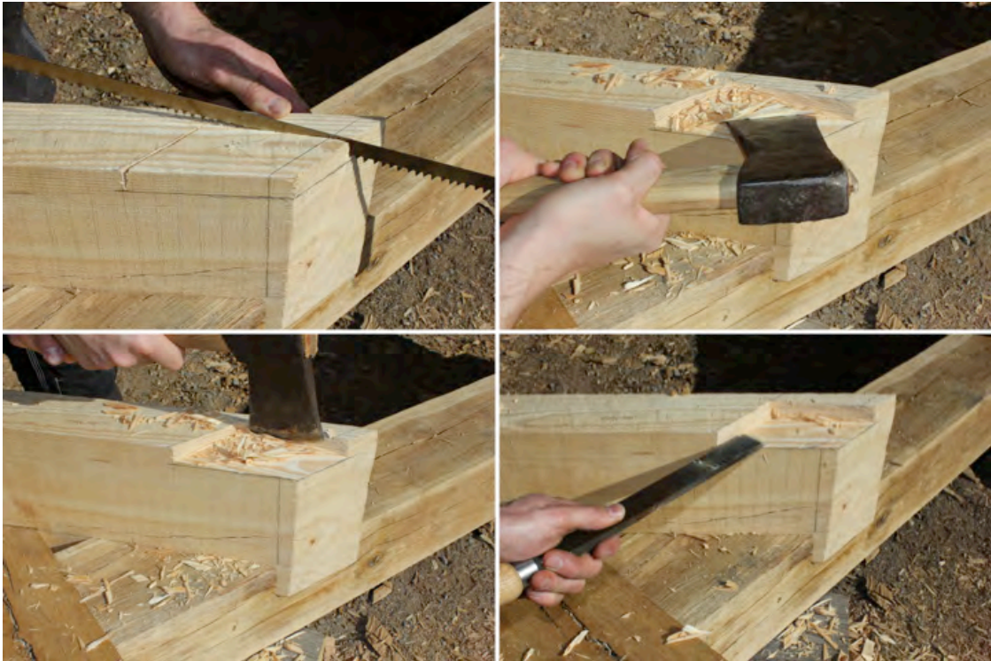
Figur 52. Hakets ytterkanter sågades ut. Därefter högs det med yxa och finjusterades med ett större stämjärn.
