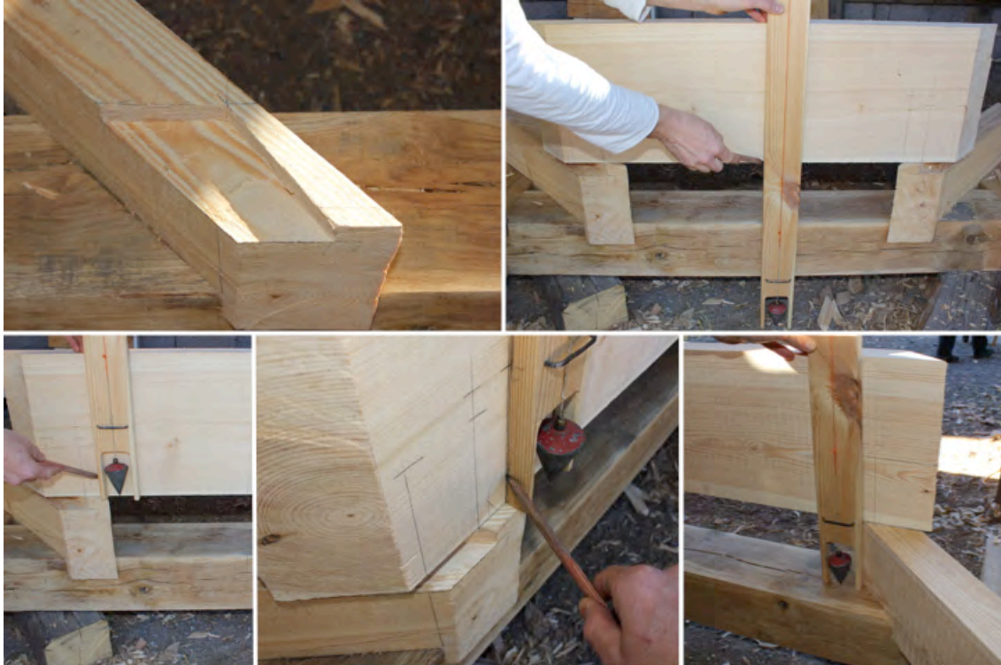
Figur 62. Efter att överhaken var färdig huggna, inplacerades timret i våg och lod. Sedan avsattes på mitten ett lodstreck både på timret och fotträet för dubbens placering, enligt att "tolka upp en dubb" . För fortsättning se Figur 69. Det övre "små låshyggena" överfördes till det nästkommande timret, både på framsidan och baksidan. Det underliggande timrets baksida, som kommer att utgöra markering för sågning av underhaket, överfördes. Viktigt att överföringen gjordes noggrant för att få en tätslutande anläggning och för att slippa ta mer.
