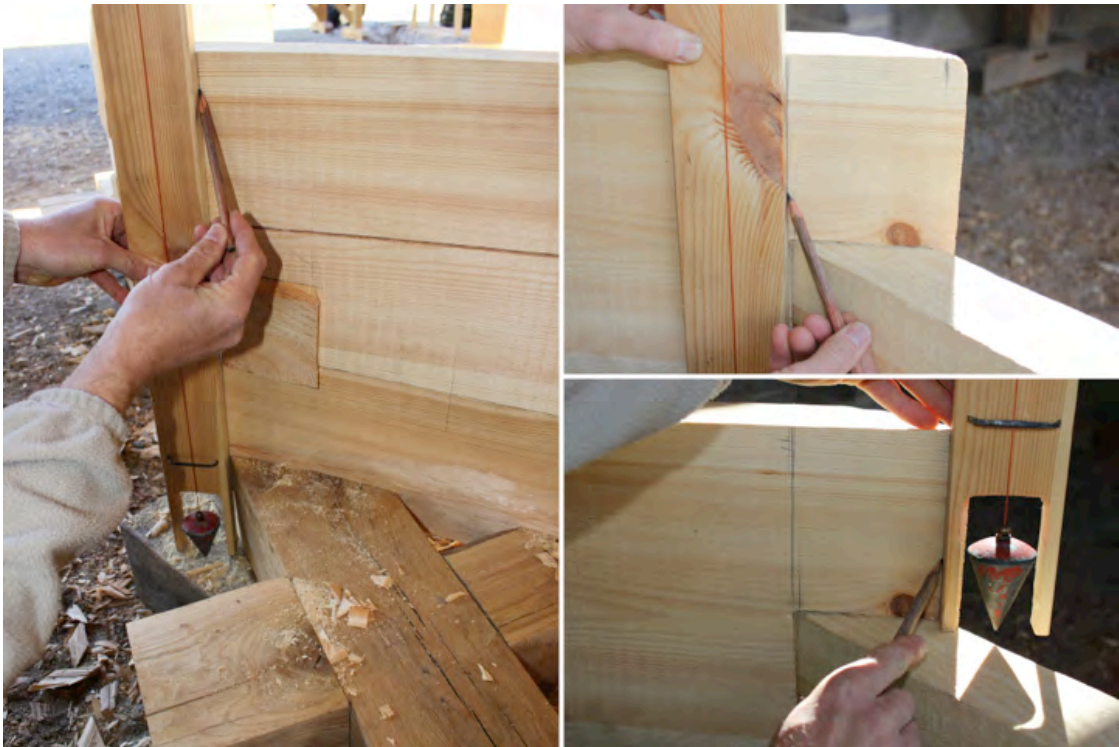
Figur 53. Överhakets placering lodades upp, både i framkant och bakkant, utefter det underliggande timret. Detta gav också, på baksidan timret, de linjer som behövdes för uttag av vinkeln [halva diagonalen]. Lodades det bakre strecket upp och inte avsattes med det timret som skulle timras in, se Figur 49, fick det beaktas vid utsågning, att den gjordes en bit in för att inte skapa hål i bakkant knut, i fall timret var något smalare.
