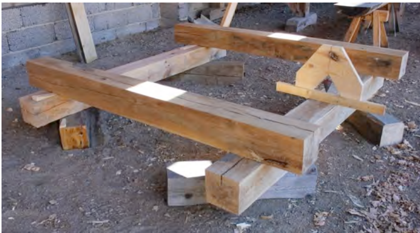
Figur 20. Utplacering fotträramen för pårättning av hak och injustering i våg.
