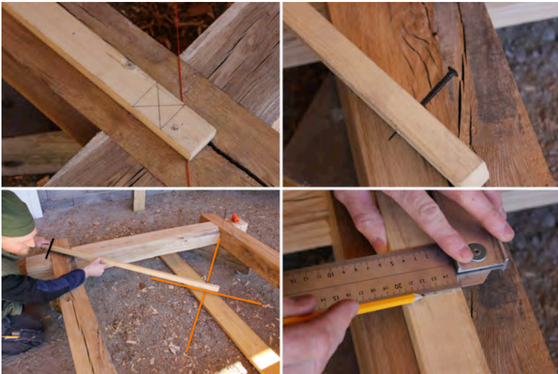
Figur 9. Mittpunkten uttagen i änden på läkten. Ett smitt spik slog rakt igenom så att en bit av spiken stack fram och kunde skapa en rits. Läkten – passarens längd togs fram genom att hålla läkten så att den genomslagna spikens spets tangerade krysset av de uppspända snörena för fotträramens mittpunkt. Därefter avsattes en markering i andra änden läkten, där den tangerade fotträramens yttre hörnpunkt, se svart markering. Markeringen vinklas upp med vinkelhaken.
