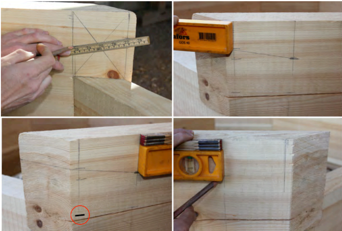
Figur 56. Markeringarna sammanbands. Fortsättningsvis överfördes måtten på knutens framsida med passaren, genom att halva uppsticket avsattes i knutens framkant från ovankant timret och halva diagonalen avsattes i knutens bakkant ovankant timret, se även Figur 60. Vid påritning framkant finns inget timmer i underkant att lägga an passaren emot. Då kan även det total uppsticket överföras till utsidan, se svart markering röd ring. Därifrån avsätts sedan halv diagonalen uppåt. Här provades också som bilden visar att med verktyg föra över måtten. Detta motsvarade användandet av mall. För framkant funkade vattenpasset höjd och för bakkant vattenpasset plus tre tumstocksblad. Anledningen att detta gjordes var att visa på hantverkarens tankesätt, att använda det som finns till hands. Kanske var det många gånger det som styrde vilka mått och vinklar som användes. Det kan också ge en förklaring, vid jämförelse emellan, till varför mått och delar inte alltid stämmer exakt överens med litteraturens angivelser.
