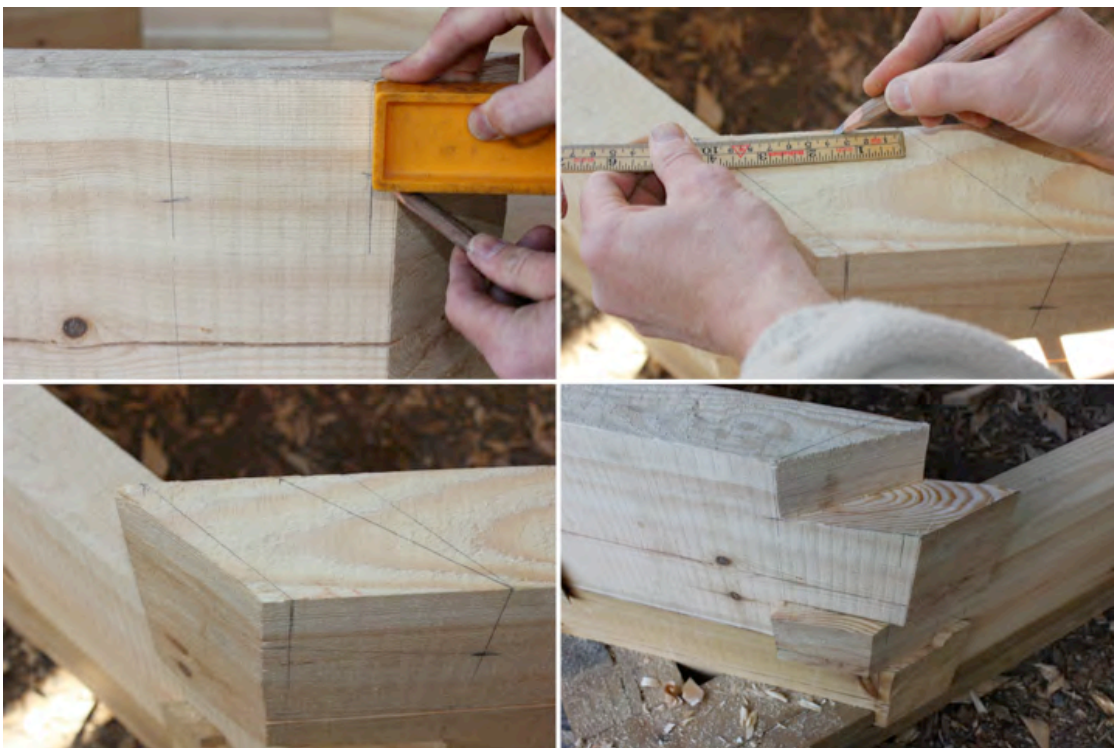
Figur 57. Måtten påritades och överfördes på samma sätt för den motsatta sidans överhak, som vid Figur 56. Halva laxstjärtens snedställdhet påritades med tumstock, mått enligt Figur 54. Haket sågades i bakkant och sedan högs det ut med yxa och ev. finjusterades det med större stämjärn.
