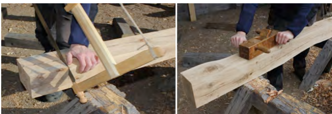
Figur 18. Kapning av fotträna med ställningssåg och justerhyvling av fotträ med oxhyvel.
