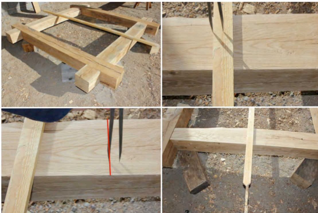
Figur 30. Läkten placerades i mitten på fotträramen genom användandet av tidigare centrumlinjer för påitning av ramens yttermått. Det gjordes genom att läktens halva bredd togs ut med passare och fördes över till fotträramen. Den sattes av från röd markering, som avser centrumlinje. Likvärdigt gjordes på motsatta sidan av fotträramen. Läkten placerades kant i kant med den påritade markeringen för att få läkten i centrum fotträram. För centrering längdled användes tumstock.
