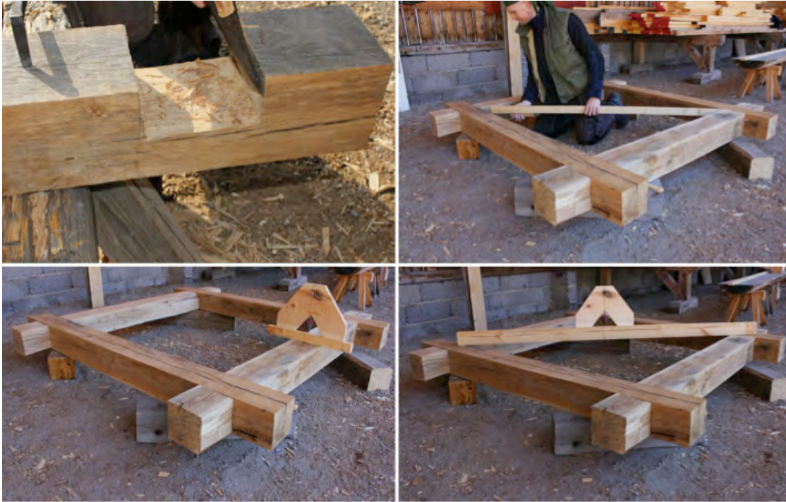
Figur 26. Vid sammanfogning av fotträramen fick viss justering av haken göras. Efter sammanfogning kryssmättes ramen och lod/våg kontrollerades.
