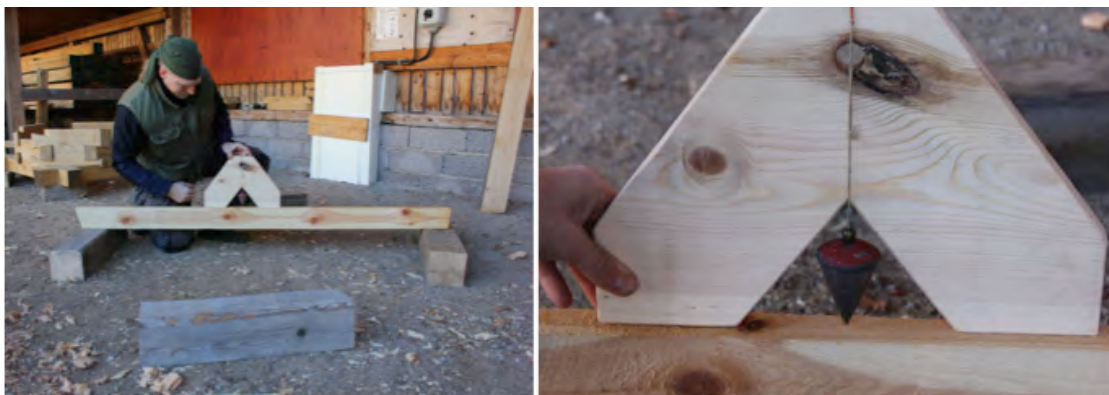
Figur 17. Invägning med äldre vattenpass.
