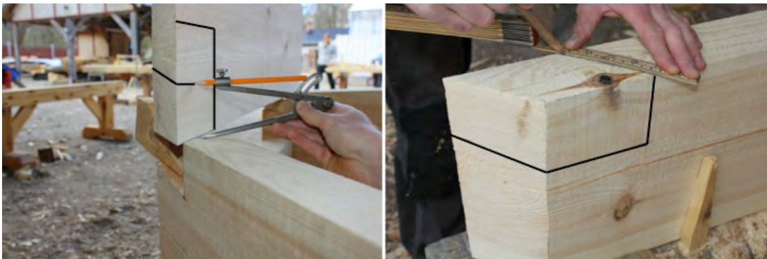
Figur 67. Passaren ställdes om för att kunna dra/rita på höjden, på timrets baksida, för den del av knuten som ska sågas bort. Timret placerades upp och ner i timmerbocken och markeringen för den del av underhaket som skulle sågas bands samman.
