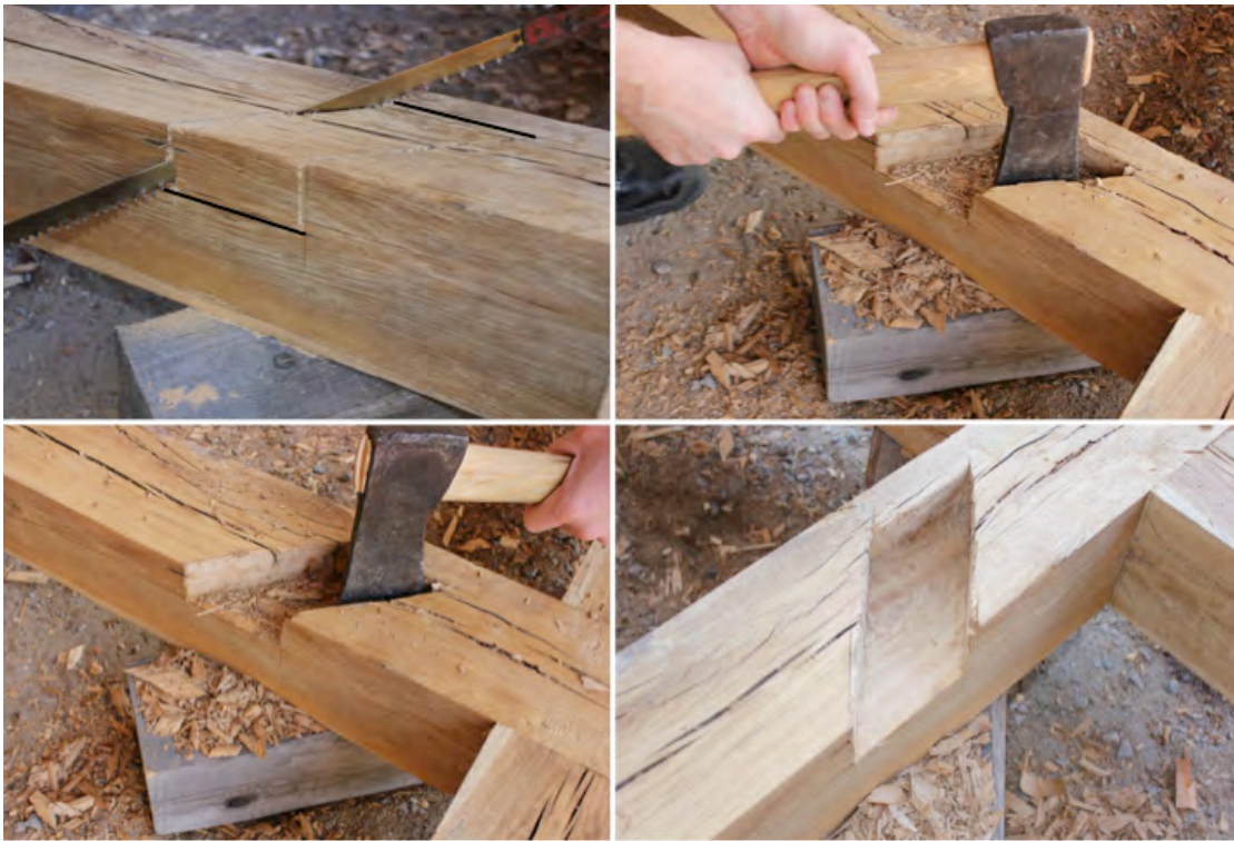
Figur 36. Hakets yttersidor sågades, bild visar det djupaste som kunde sågas pga. låsnacken i bakkant. Haket höggs fullt ut med yxa, så när på finputsning där ett större stämjärn fick användas för att komma till.
