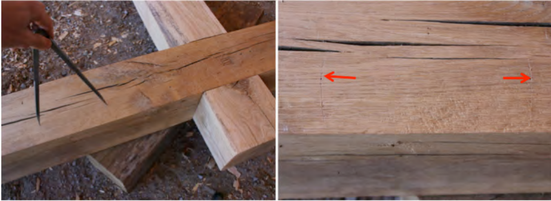
Figur 3. Vid användning av passare med bara stålben, avsattes sänkingsavståndet ("dropping distance") på fotträramen för den sidan som det arbetades med. Det utgjorde en minnesmarkering om passaren skulle ändras.
