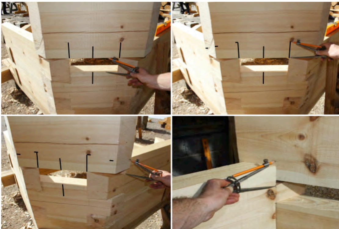
Figur 68. Likvärdigt förfarande som Alt. 2, fast här kunde timret vila i överhaket och inga kilar behövdes. Detta gav ett lättare och stabilare påritningsarbete. Timret placerades i lod och våg. Underliggande haken och dubbens placering lodades upp. Sänkingsavståndet mellan timren togs med passare och påfördes underhakets fyra hörn.
