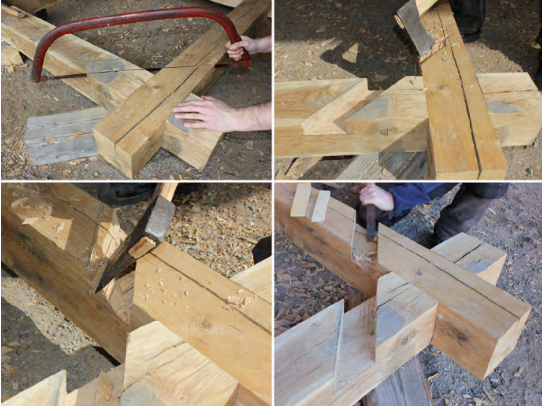
Figur 39. I fotträramen "... sågades snedhyggen i på övra kanterna"(Nm 33 E.U. 2578, Tillägsblad s. 135). Ytterkanterna sågades, resten höggs med yxa och finjusterades med större stämjärn. Försänkningen gjordes 2" djup och i timrets tjocklek [3"]. Påritning gjordes med tumstock.
