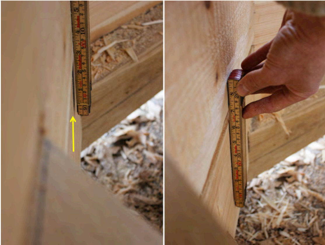
Figur 74. Holmberg redogjorde för ”hugga för hänge” när timren var krokiga eller skillnad i bredd förekom (Nm 11 E.U. 2579). Detta gjordes för att det inte skulle bli glipa, mellan det undre och övre stocken efter mejhuggningen, när timret slogs ner för gått. Alltså fick kontroll av timret och förfarandet ske innan mejningen gjordes. Viss dimensionsskillnad, ca 5 mm, fanns mellan vissa av timren som gjorde att ”hugga för hänge” provades. Gul pil visar skillnaden mellan underliggande timret och det som ska timras in. Bilden t.h. visar timren efter huggningen.
