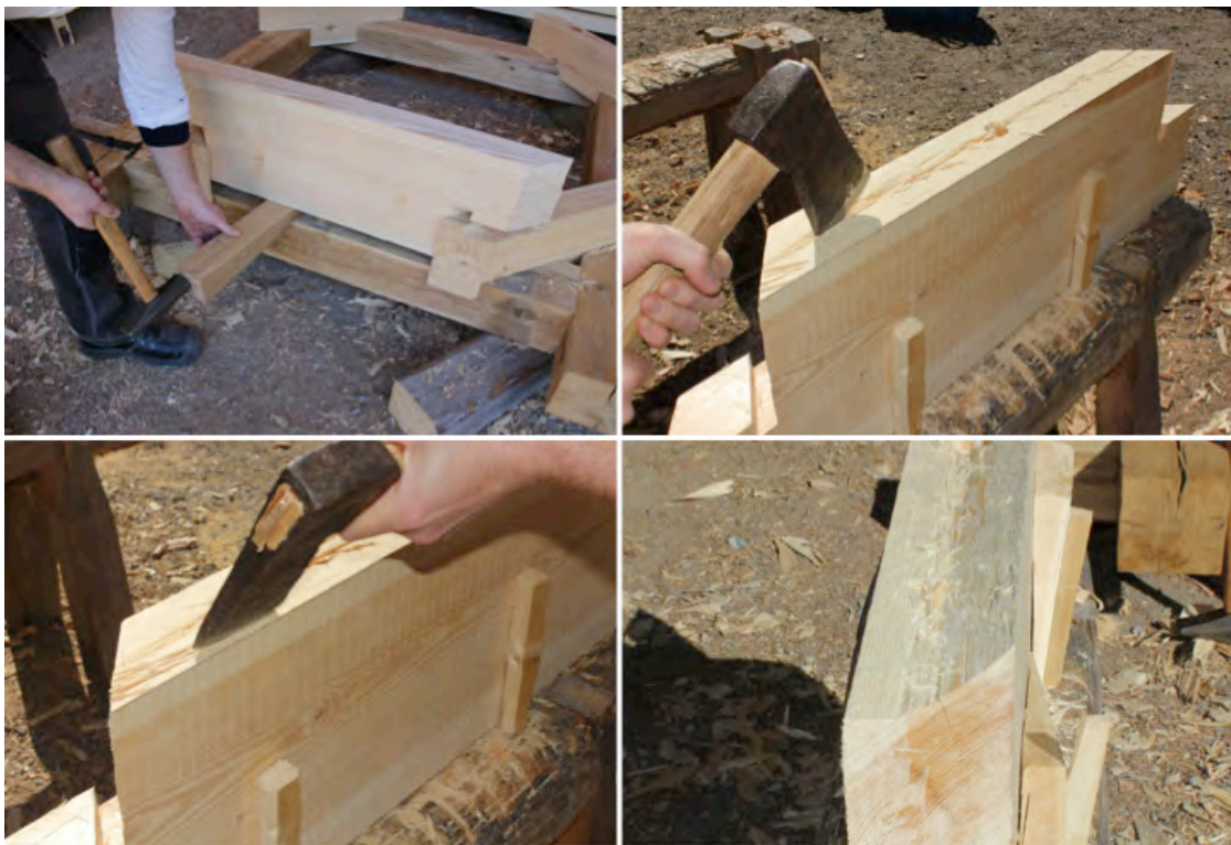
Figur 81. Avlyftning av timret gjordes enligt Holmbergs beskrivning med användning av en timmerkil i ek. Den tillverkades enligt Holmbergs mått; 24" lång och 3" bred. Kilen var effektiv och ett bra hjälpmedel som kommer att användas även vid fortsatt timring. Därefter gjordes mejhuggningen enligt Holmbergs beskrivning. Först höggs timret i mitten med bakfjäten på yxan, för att sedan huggs från sidan i ca 30°-lutning. Huggning med bakfjäten fick göras med försiktighet annars kunde det ge ansats till att spräcka timret och då främst i dess ändträ. Detta upplevdes mest gälla furutimret och inte lika mycket med ektimret vid Hantverksfördjupningen. Mejhuggningen gjordes likvärdig alla knutar.
