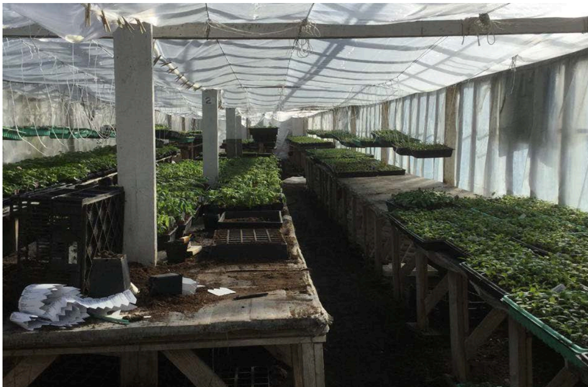
Figur 2. Alla odlingshusen är av äldre typ med glas och träprofiler. Under tidig vår är husen plastade invändigt för att hålla värmen bättre.
