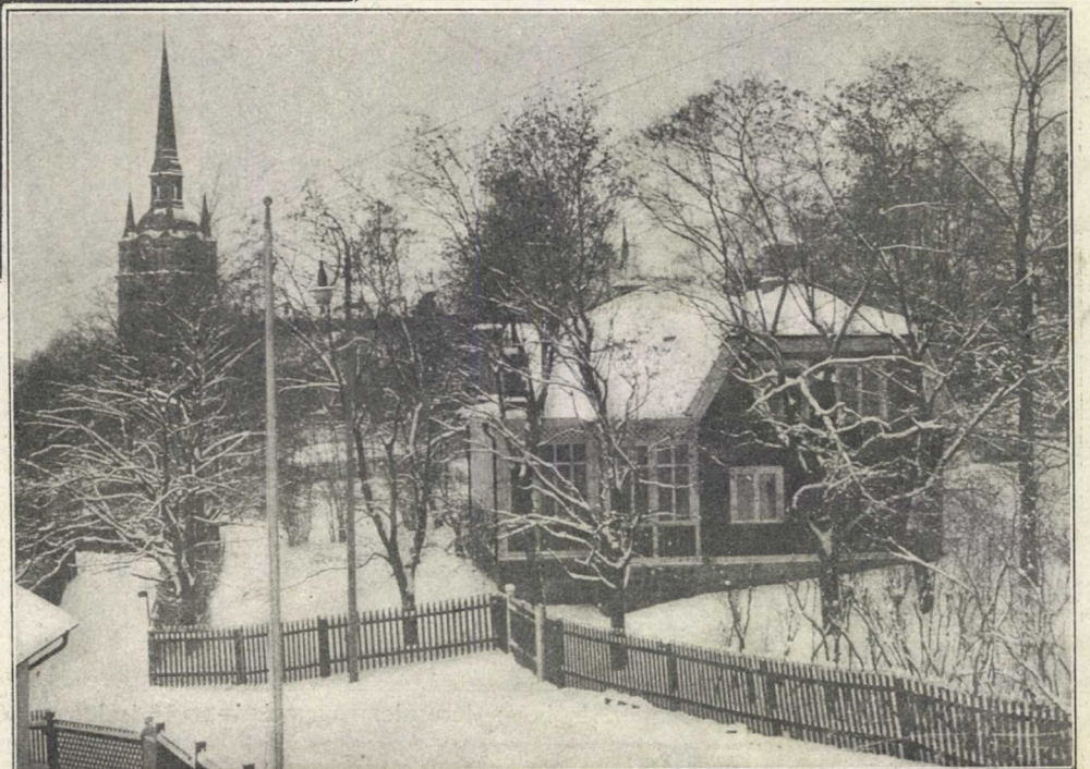
Exteriör af villan med Kopparbergs kyrka i fonden. Axel Häggmark foto.
