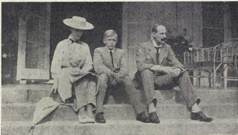
Kungafamiljen på trappan till Bygdö kungsgård.
