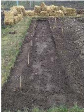
En 10 cm djup ränna grävs ut där bänkens material ska ligga.
