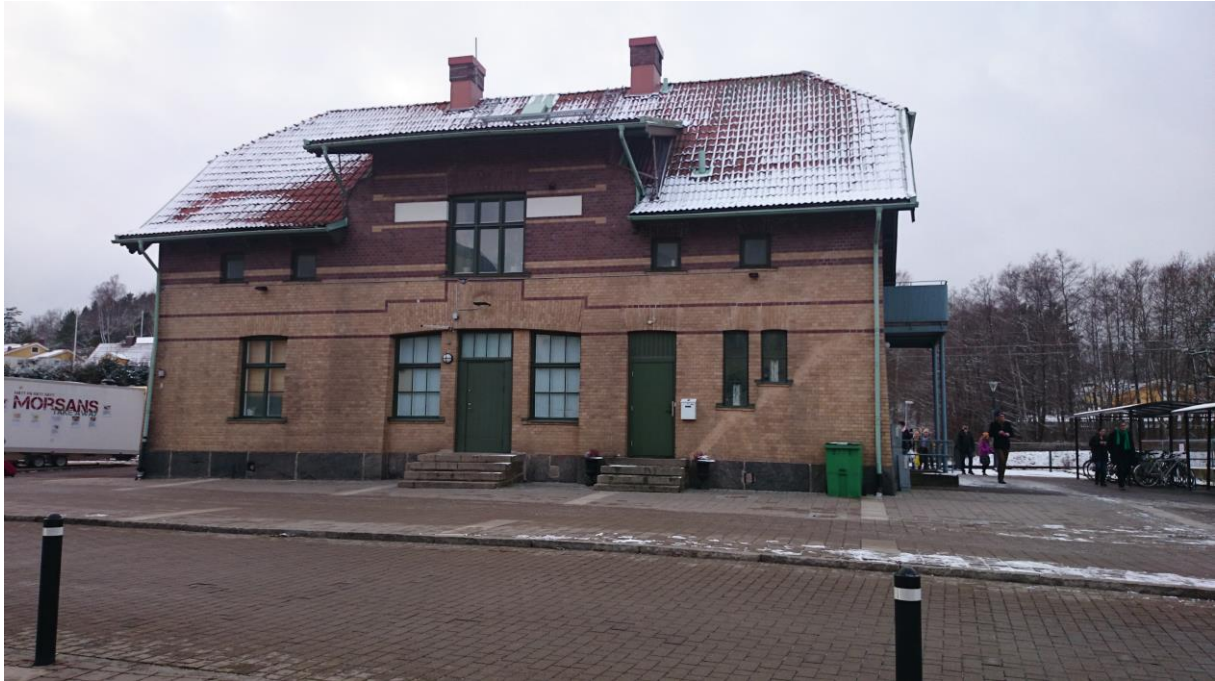
Bild 1 Stationshuset i Ytterby (källa: egen bild).
