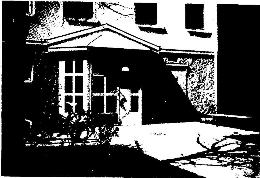
Nya utbyggnader till trapphusentréerna i Valla
