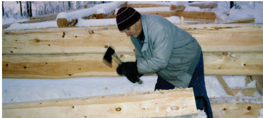
Bilde 1. Roald Haugli grovhogger medfar på ein røstkabbe (stokk i røstet) på eit naust som vart tømra i Målselv og sett opp i Kabelvåg i 1997-
