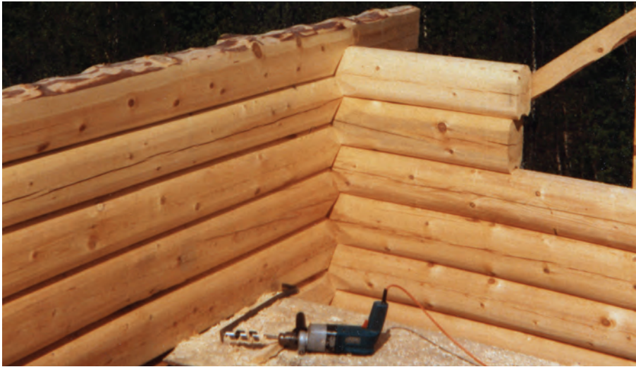
Bilde 2. Tømring i Hauglia etter at boremaskina vart vanleg. Her er vegg-tømmeret runda. Foto frå Roald Haugli sitt fotoalbum.
