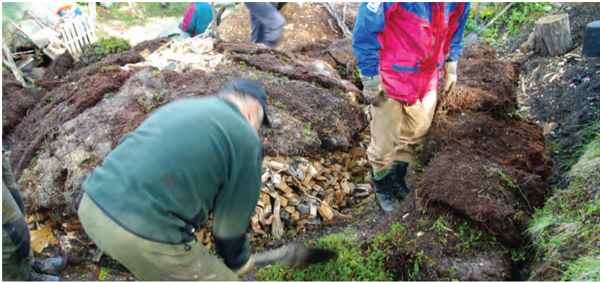
Bild 14. Hela milan ska täckas med torv, utom den nedersta delen vid marknivå, vilken täcks först när milan tänts.
