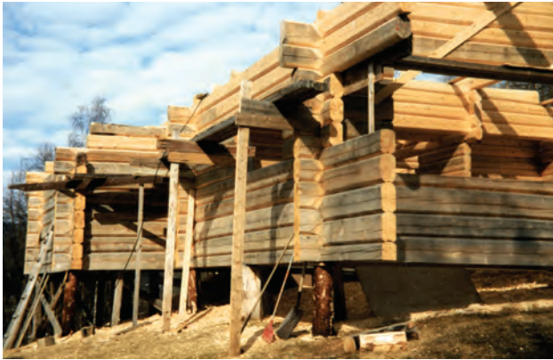
Bilde 5. Ei av dei større hyttene Svein Haugli tømra på Haugen. Her har han brukt den vanlegaste forma for stillinger. Doble ribord som er spikra i novene inne og støtta med eit røys ute. Vandringa ser ut til å vere 3" plank. Foto frå albumet til Roald Haugli.
