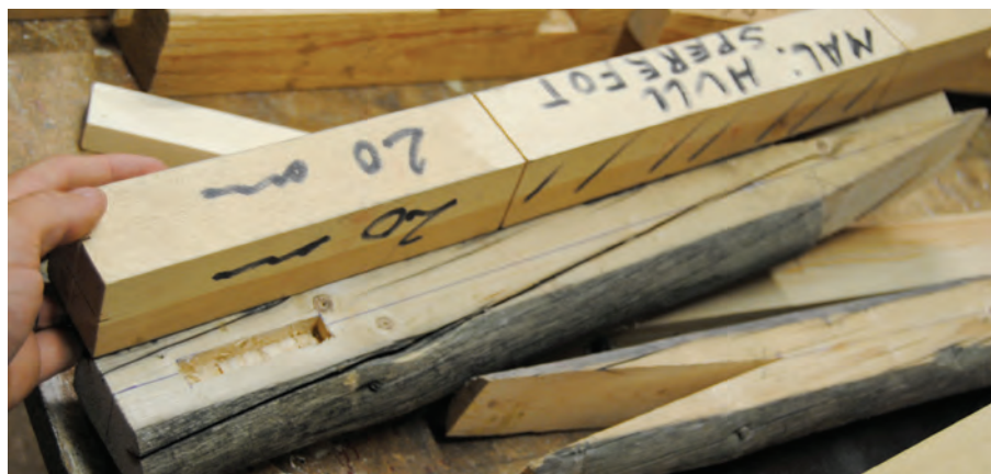
Billede 7. Mærkestaven til taphullet på undergurten. Foto: Ulrik Hjort Lassen.
