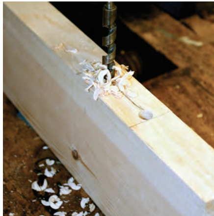
Bild 19. Först borraras hål i ytterkanterna.
