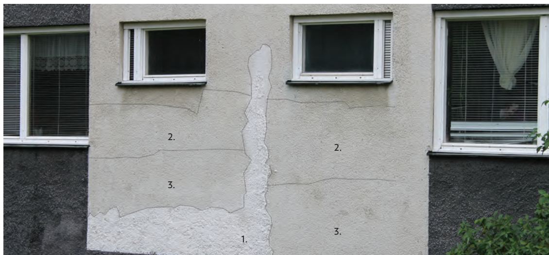
Bild 10. Tre olika lagningar på samma fasad.
