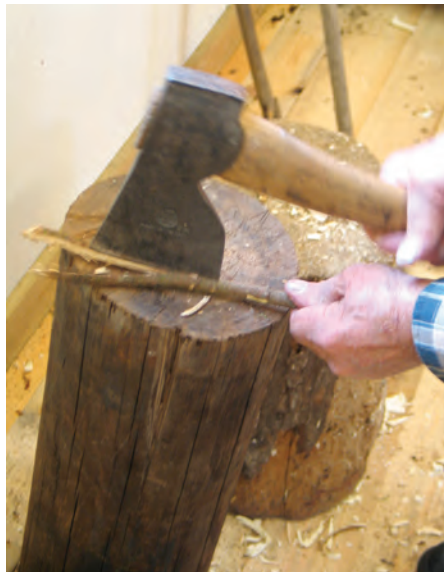
Bilde 9. En gran kløyves i to og gir virke til to ribber. Han legger granen på huggestabben, og splitter den tykke enden med øks.
