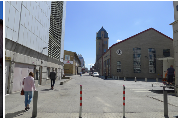
Fig. 19: F.d. ångpannehus, idag restaurangskola. Arkitekt G. Wickman
