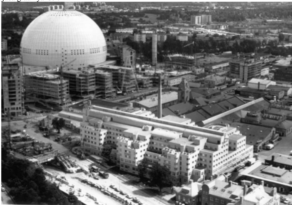
Fig. 8: Globenkomplexet under uppbyggnad och de nya kontors- och servicehusen i Slakthusområdet i förgrunden, 80-tal. (Bild hämtad ur Saluhallsstyrelsens jubileumsskrift 2002)
