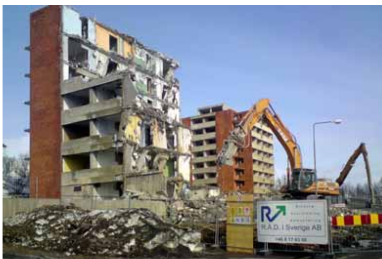
Fig. 24. Terrassen. De sex punkthusen på Terrassen uppfördes under Kirunas expansion på 1950- och 60-talen, men tre av dem hör till de byggnader som kallställdes när befolkningen minskade under 1990-talet. Rivningen av dem påbörjades april 2010.
