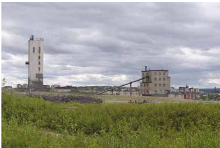
Fig. 7. Luossavaara industriområde. Gruvdriften är nedlagd, det som syns på bilden är gruvlave och sovringsverk. Industriområdet är beläget på en del av marken som kan komma att bebyggas enligt det nordvästra utbyggnadsalternativet för det nya Kiruna.
