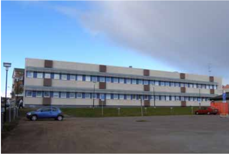
Fig. 20. Centralskolan. Byggnaden uppfördes 1972, som ersättning för den gamla Centralskolan som då revs. Den gamla Centralskolan hörde till Kirunas offentliga byggnader som ritats av Gustaf Wickman.
