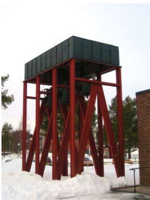
Bild 3. Örnäsens kyrkas klockstapel tillverkad av plåtbalkar.
