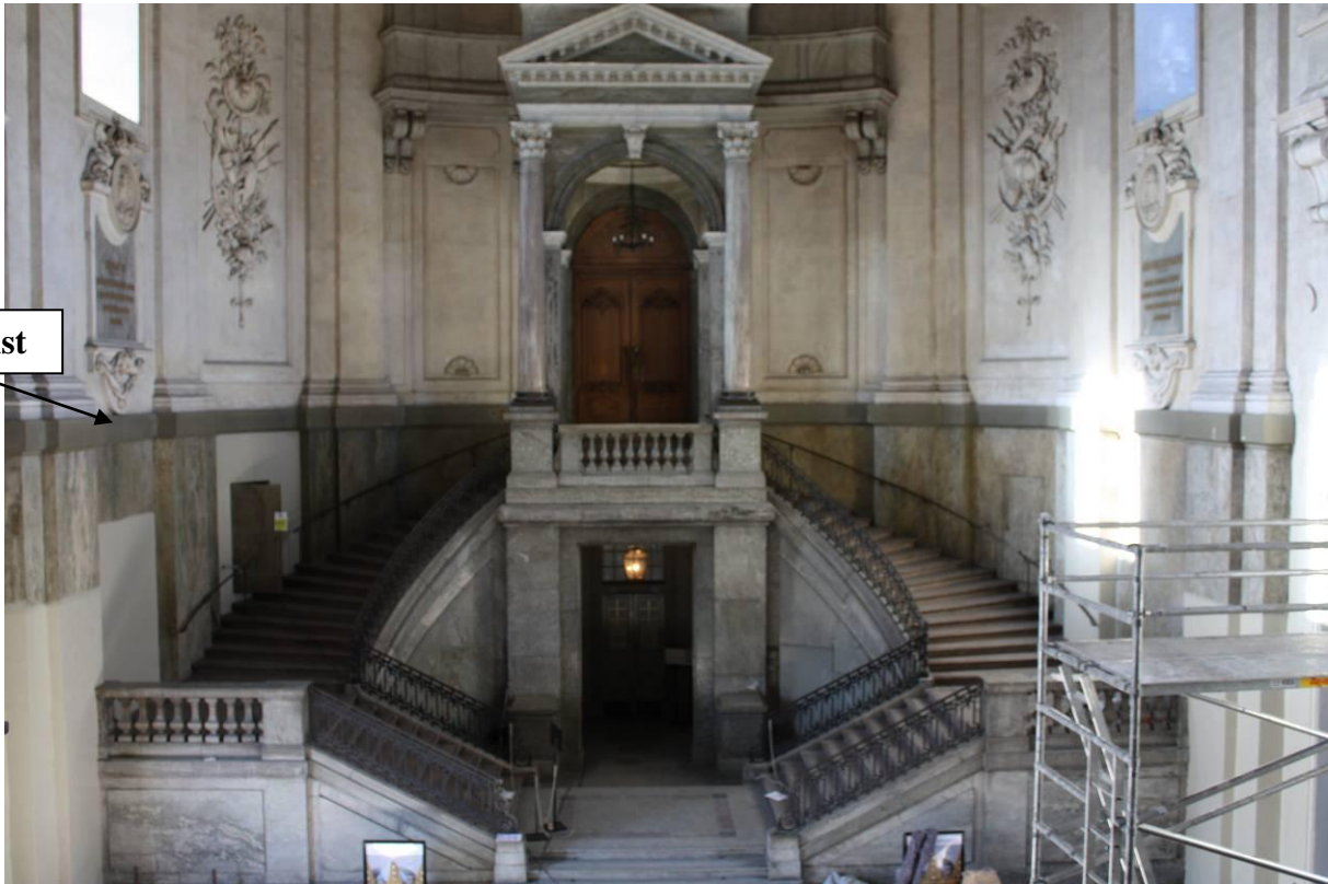
Bild 1 Södra valvet sett från ingången till slottskyrkan. Den stora porten mittemot är ingången till rikssalen. Åt vänster i bild kommer man ut på slottsbacken och åt höger in på borggården. Gördellisten är utpekad med pil.
