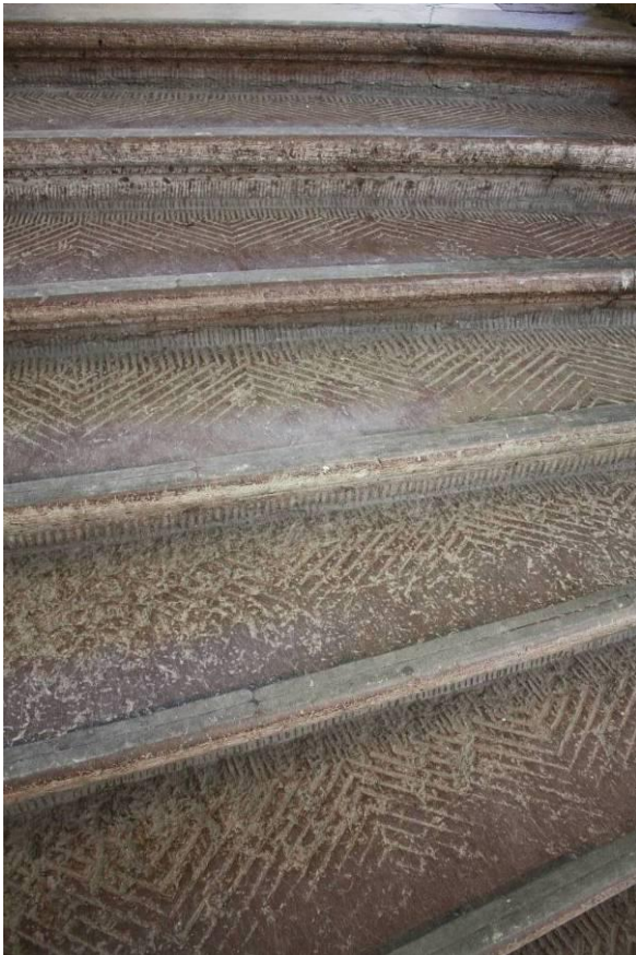
Bild 6 Trappsteg i södra valvet
