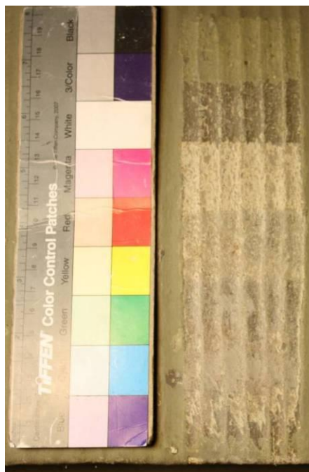
Bild 8 Färgtrappa på norra väggen, bredvid porten till inre borggården.
