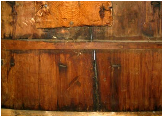
Figur 15. Inhugget från yxa ses som ett diagonalt hack i plankan på högra dörren.
