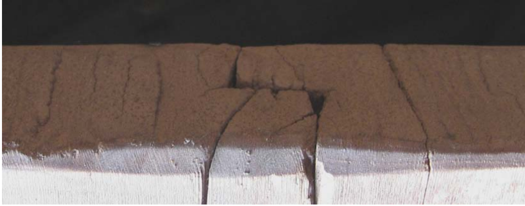
Figur 27. Falsen i ovkant på högra dörrbladet i Hedninghuset.
