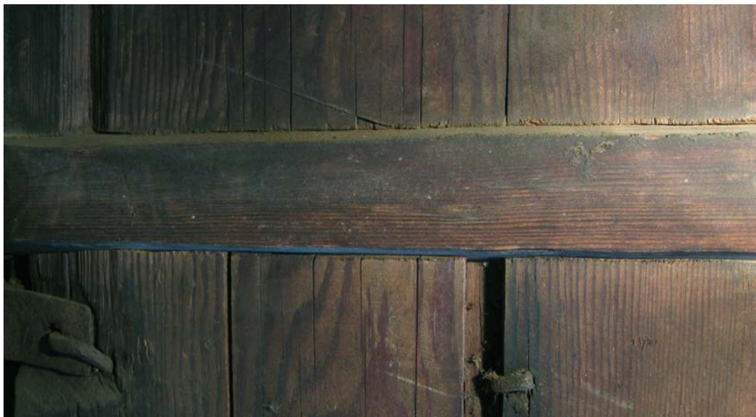
Figur 14 Naran är platt på utsidan och dess kanter är skarpa.
