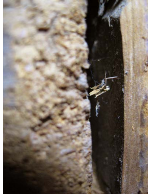
Figur 39. Botten på gradspåret har en slät och något konkav botten
