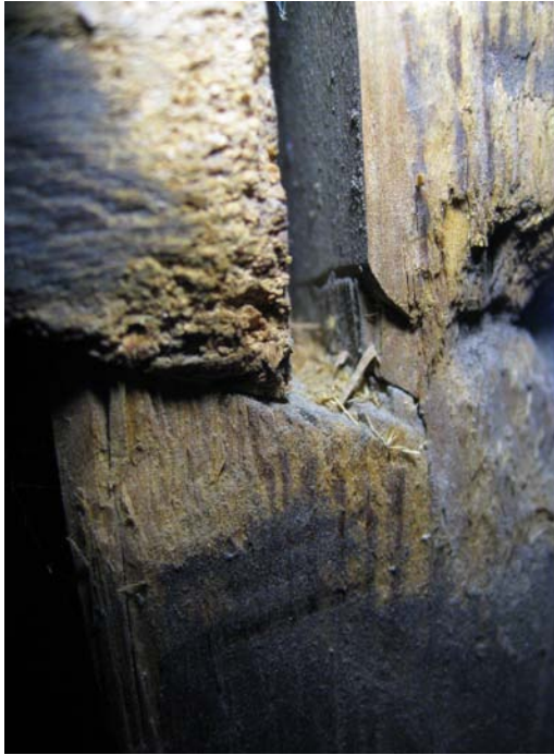
Figur 38. Närbild på gradspåret sett från sidan. I hörnet syns spår från yxa.
