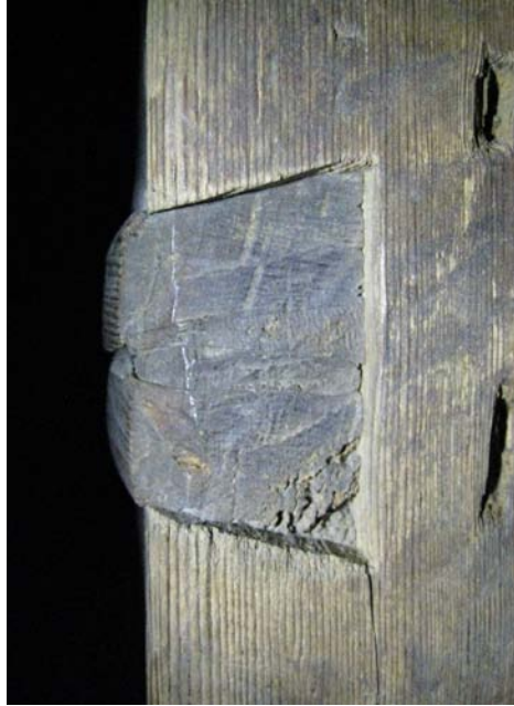
Figur 65. Kanten av Hedninghusets vänstra dörrblad, hålen till höger skulle kunna vara spår från en timmerhake.
