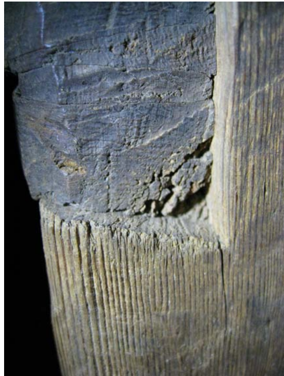
Figur 35. Närbild på gradspåret i ytterkant, både sidoytorna och botten på spåret är släta. Inga tydliga huggspår syns.
