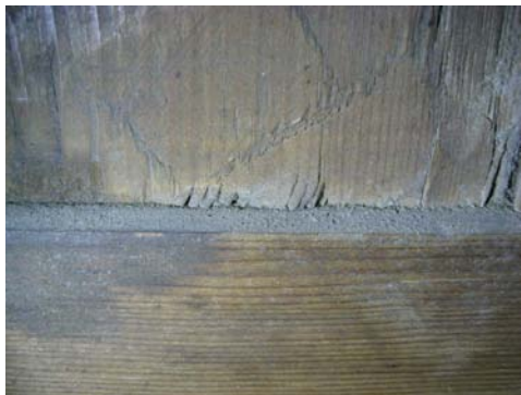
Figur 36. Närbild på ovansidan av naran, spåret har varit så pass tajt att fibrerna har gett vika.
