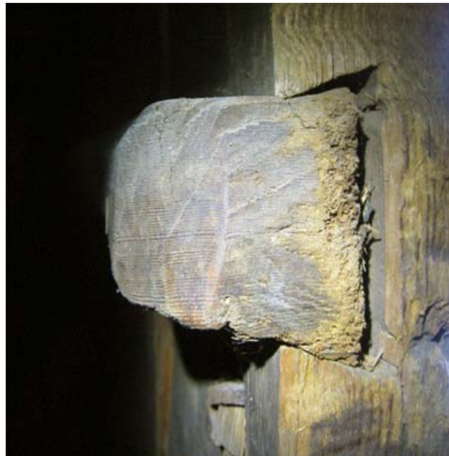
Figur 31. Ändarna på narorna har en kort eller ingen avfasning alls.
