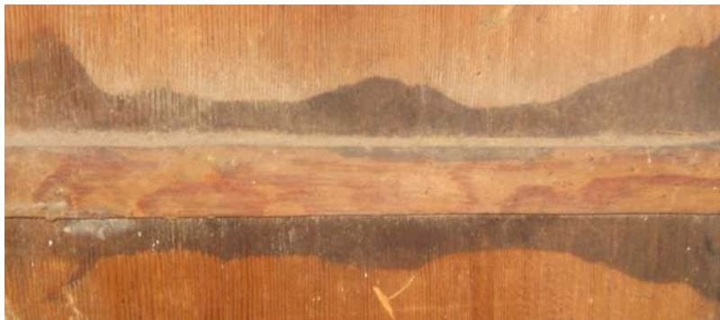
Figur 17. Närbild av nara på höger dörr. Här syns att skavspåren börjat en bit utanför naran.
