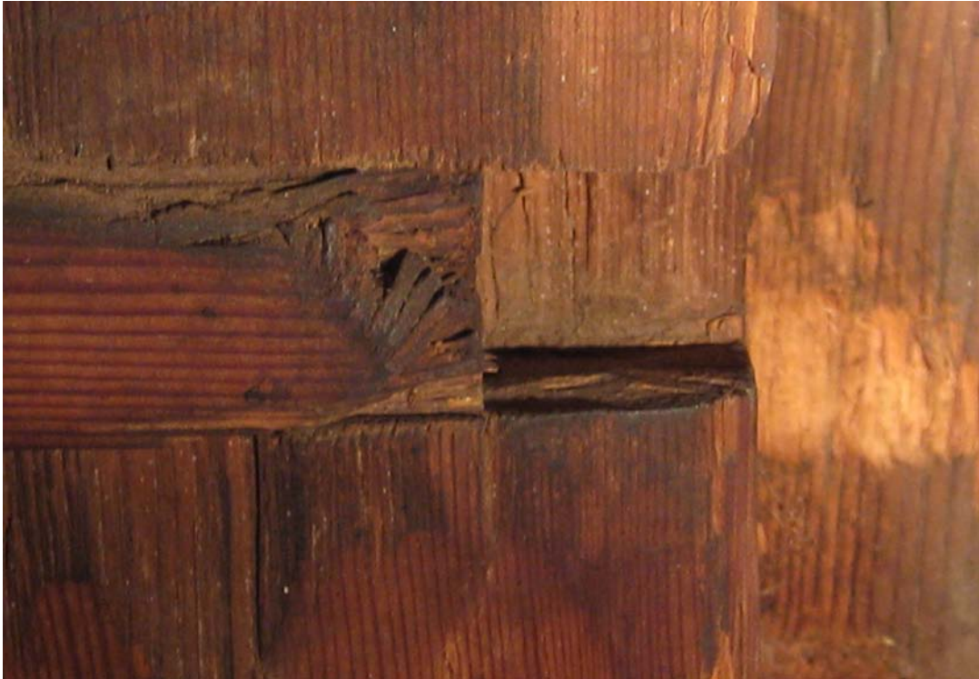
Figur 20. Här syns botten och sidorna i det gradade spåret.
