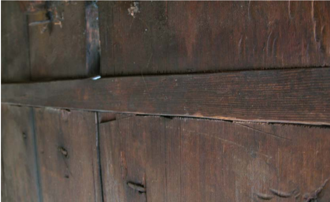
Figur 18. Bågformade ritsar syns på undersidan av gradspåret.
