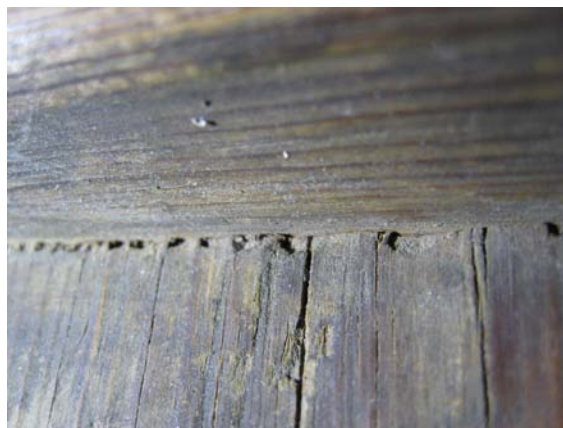
Figur 37. Närbild på underkanten av naran. En rits är dragen som markering vart gradspåret ska huggas. Ritsen har bara sjunkit in i den mjuka vårveden.
