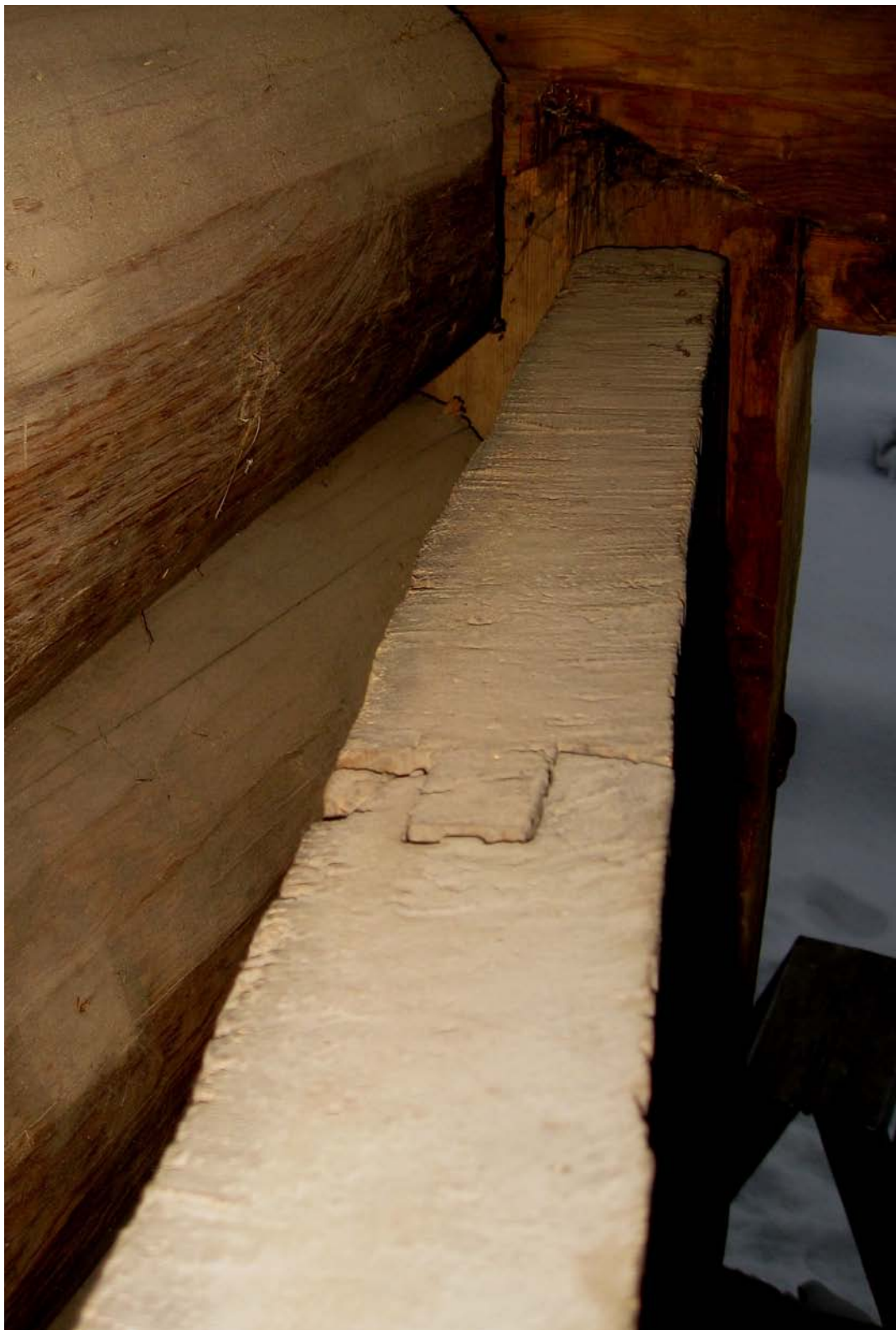
Figur 6. Vänstra dörrbladets spåntade plankor. Älvdalens Kyrkhärbre
