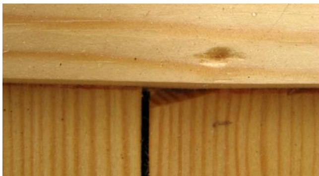
Figur 64. Närbild på skarven mellan två plankor precis under naran.
