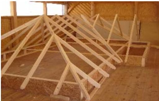
Bild 4. gradsparre med stickstolar
