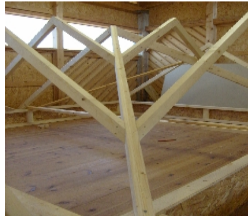
Bild 7. stickstol ansluter till kälspärre med V-spår
