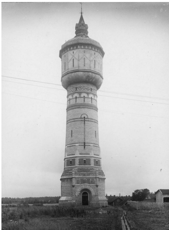
Figur 56. Likt en urnbärande pelare. Skara vattentorn, uppfört i granit, kalksten och järnbalkar vid 1800-talets slut. Foto: G. Heurlin, 1920, Tekniska museet.
