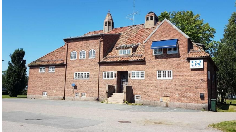
Figur 60. Åmåls varmbadhus. Foto: SW.
