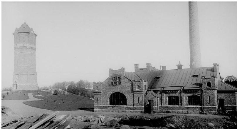
Figur 55. Eksjö vattenverk och vattentorn. Det medeltida anslaget i byggnadernas gestaltning framträder tydligt. Foto: Eksjö kommun.
