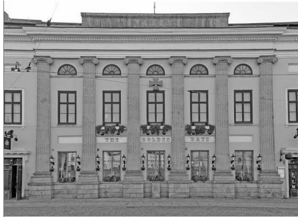
Figur 132. Frimurarhusets ikoniska fasad mot Södra Hamngatan, restaurerad av Torulf 1916-1918. Foto: Frimurarorden i Göteborg.
