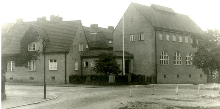
Figur 64. Den nationalromantiskt flärdfria understationen i Olskroken. Foto: GSM.
