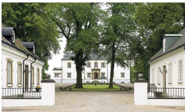
Figur 178. Storebergs säteri, huvudbyggnad och flankerande flygelbyggnader. Foto: Gods och gårdar.
