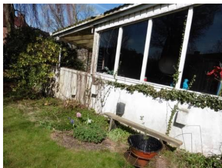
5. Muren i väst med de utstickande blocken.
